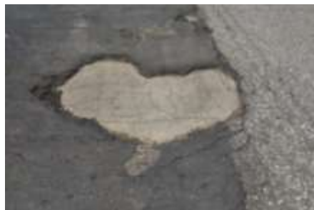
Imagen 7.3.2 Bache en áreas de movimiento de aeronaves
