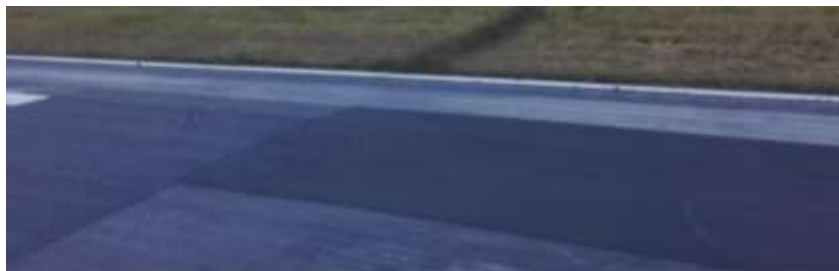
Imagen 7.3.3 Parches en áreas de movimiento de aeronaves.
