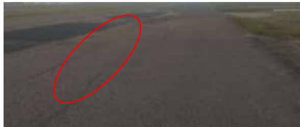
Imagen 1, Falla Longitudinal
