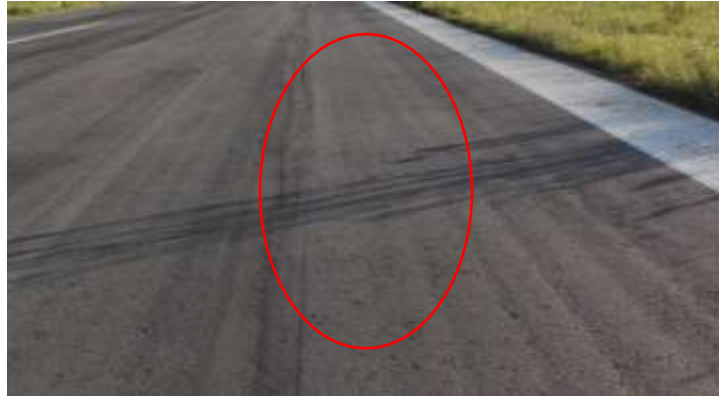
Imagen 4.3.1.1 Ondulación en una pista
