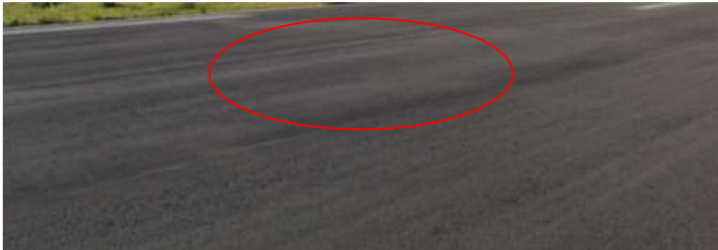
Imagen 7.2.2 Abultamiento en una pista
